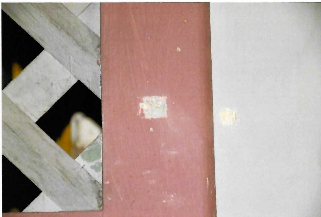
Fot.8. Modlnica, Kościół pw. św. Wojciecha i Matki Boskiej, Wnętrze nawy kościoła, Widok na fragment prospektu organowego od strony lewej , bocznej. Widoczny ubytek przemalowań i fragmenty wcześniejszych polichromii zauważalnych w odkrywce. Fot. I.Widlińska, 2023 r.
