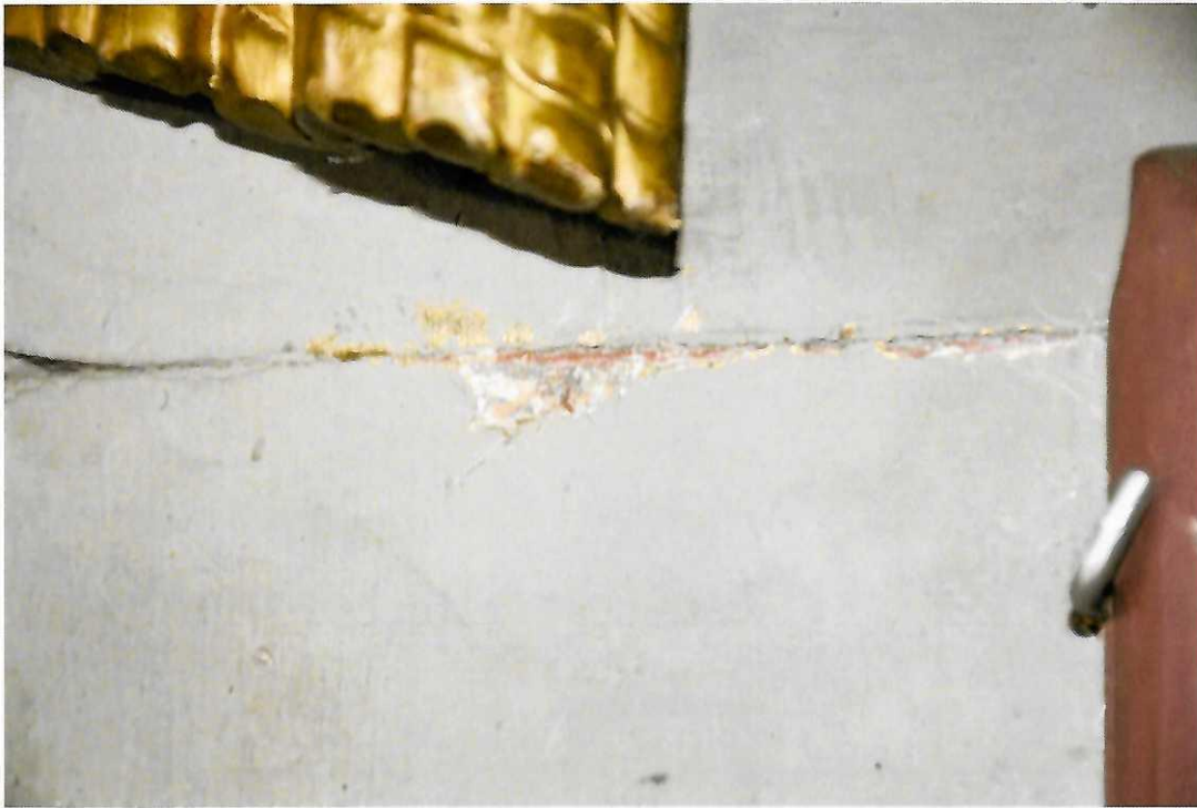
Fot.9. Modlnica, Kościół pw. św. Wojciecha i Matki Boskiej, Wnętrze nawy kościoła, Widok na fragment prospektu organowego od strony frontowej. Widoczny ubytek przemalowań i fragmenty wcześniejszych polichromii zauważalnych w odkrywce. Fot. I.Widlińska, 2023 r.
